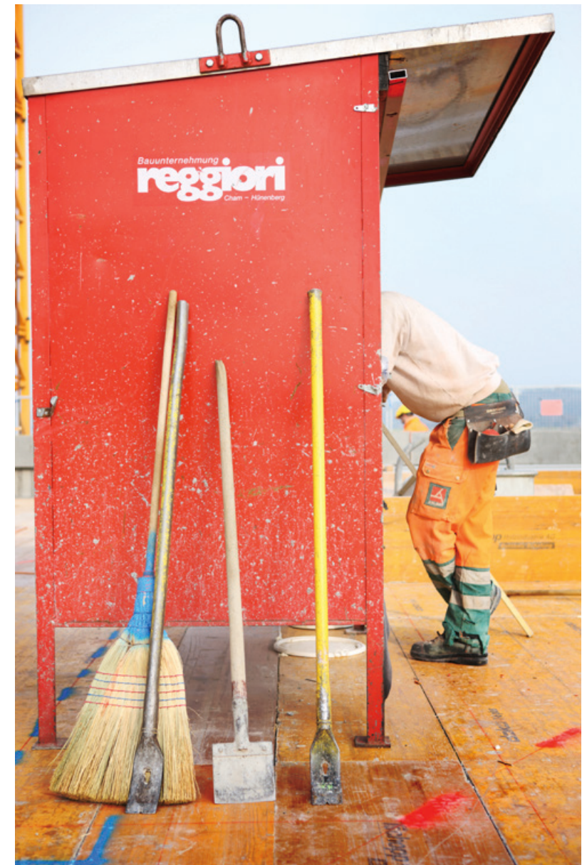
April 2010: Bauarbeiten am Mobimo-Tower.
