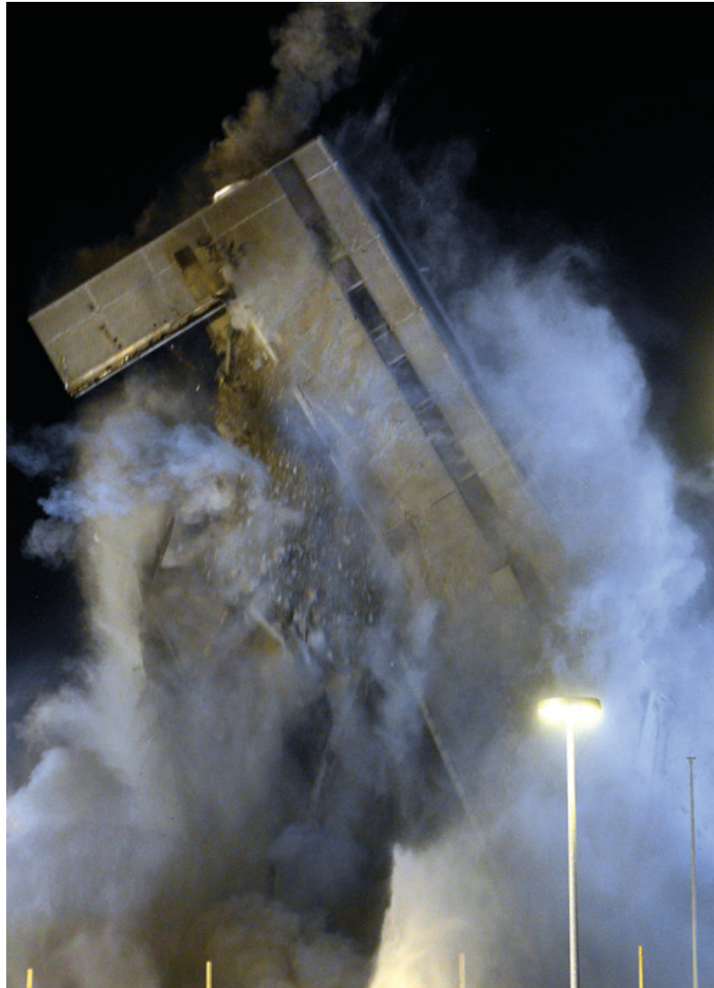
März 2013: Der Sprecherhof in Aarau wird gesprengt.
