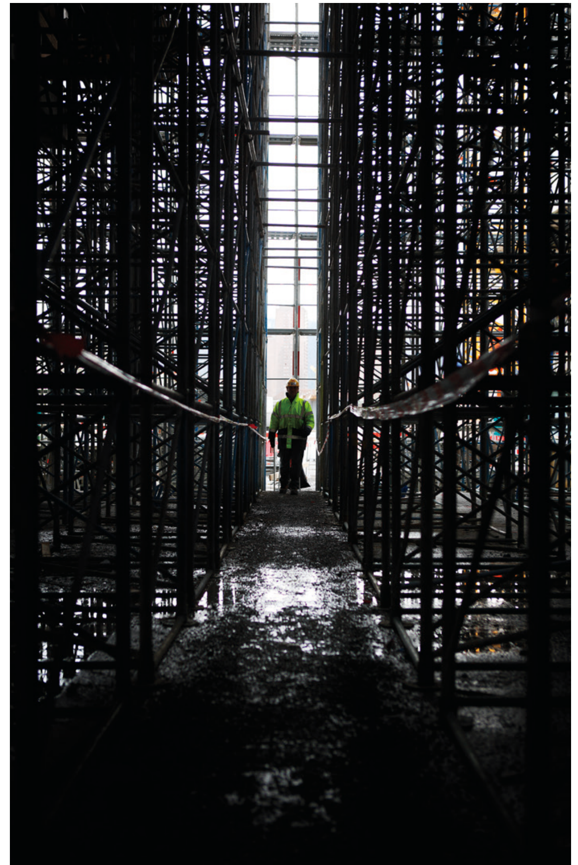
81 Meter hoch: Der Mobimo-Tower wächst, März 2010.
